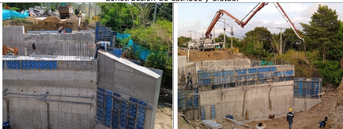
Instalación de filtros y relleno de espaldares con material de terraplén.
