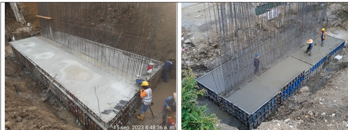
Construcción de estribos y aletas.
