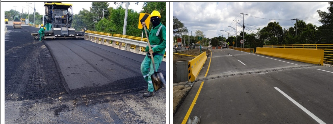
Instalación de asfalto para estructura de pavimento, construcción de New Jersey y señalización.
